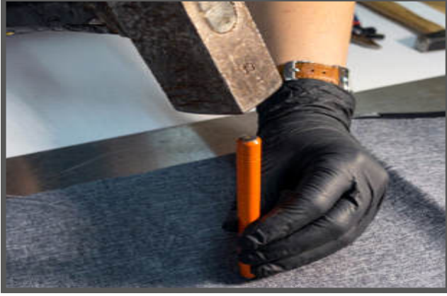
Montaj Aparatının Takılacağı Bölgenin İşaretlenmesi
